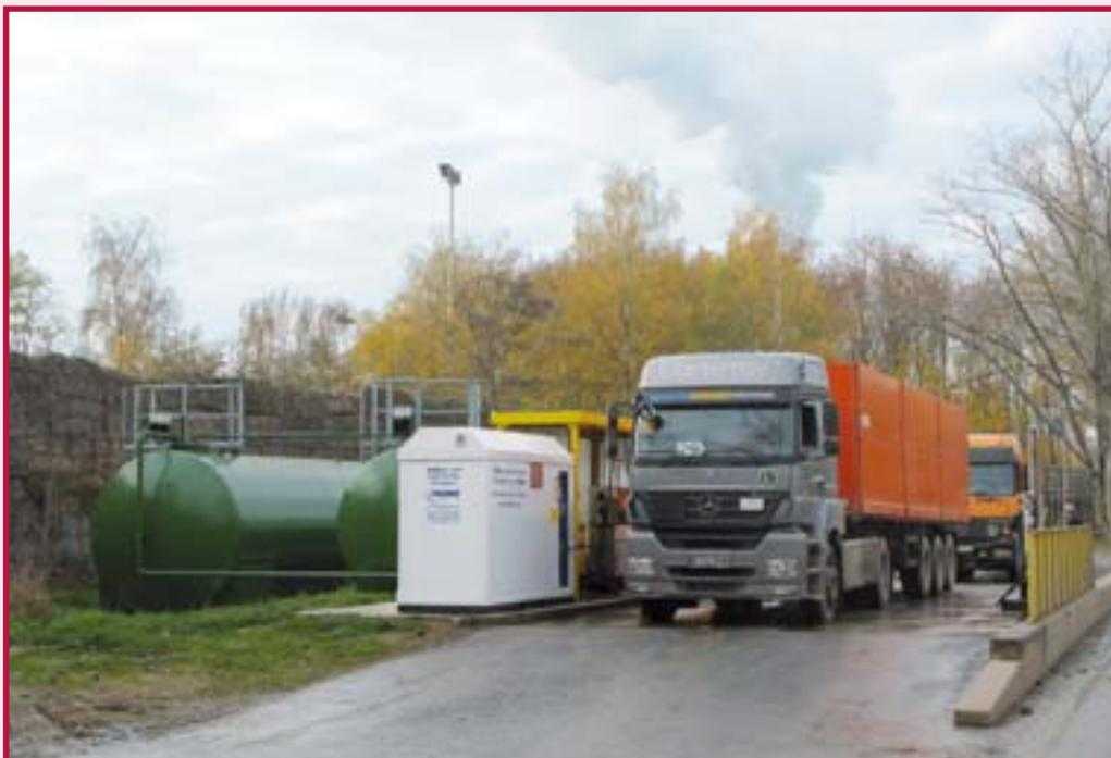
Ursprünglich auf 50.000 Liter Gesamtkapazität ausgelegt, verfügt die Tankstelle in Offstein heute über eine Diesel-Lagerkapazität von 150.000 l. Darüber hinaus steht den Transportgruppen seit der Kampagne 2008 auch eine AdBlue-Tankanlage zur Verfügung.
